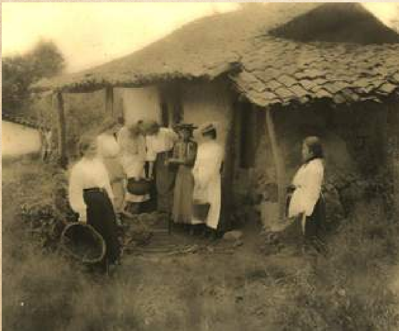
Paseo de la familia de José Fidel Tristán, Escazú, 1904. Se observa una casa de adobe, con techo de teja, mujeres con canastos, ollas de metal y balde. A un costado se aprecia un horno de barro. Fuente: ANCR (1904), FO. # 9741.
